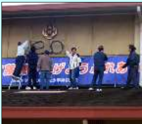
設置作業の様子
