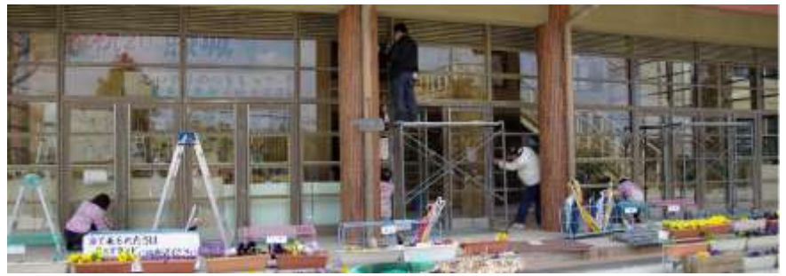
3 月 29 日 藤城小学校昇降口のペンキを塗り替えました。(藤城小学校学校運営協議会)
