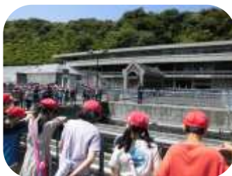
4年 腐上浄水場
